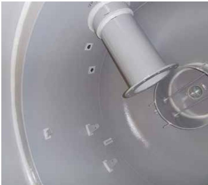
Belzona 1331 es un sistema de recubrimiento de dos componentes diseñado para proteger contra la erosión y la corrosión los equipos que operan en condiciones de inmersión continua con temperaturas de hasta 50 °C.
