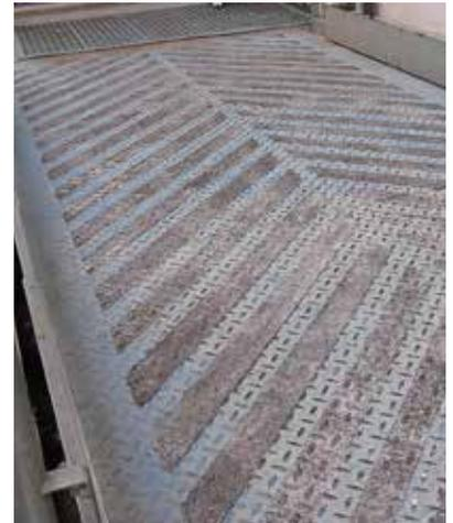
Rampa con franjas de Belzona 1821
