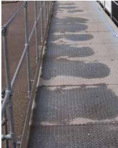
Rampa de acero pulida antes del recubrimiento
