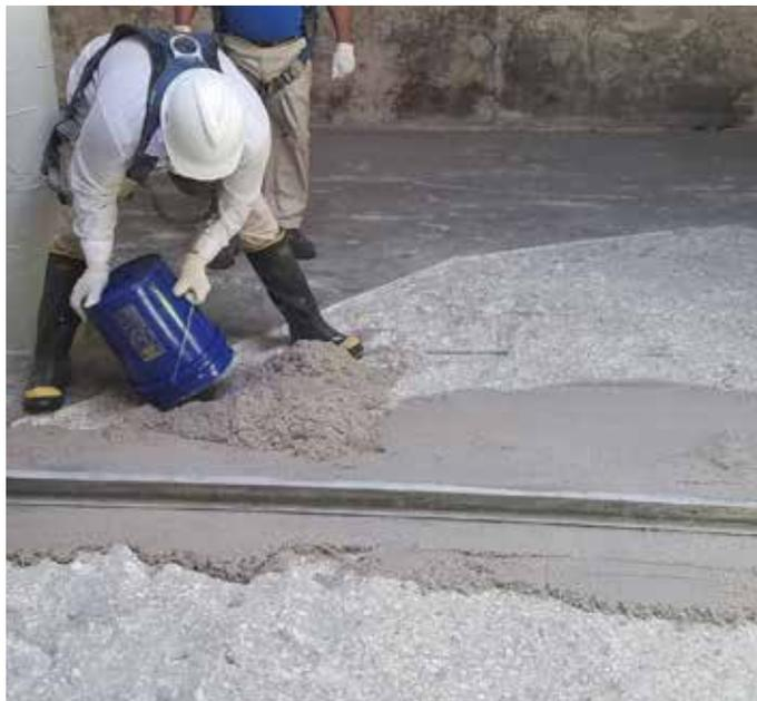
Belzona 4154 es una resina de base epoxi diseñada para mezclarse con agregados fácilmente disponibles, como arena, cuarzo o piedra triturada. Es una solución de reparación económicamente rentable, segura y fácil de aplicar.
