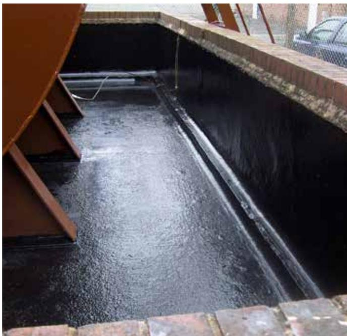
Belzona 4351 es un recubrimiento disipador de estática de dos componentes diseñado para transferir la acumulación superficial de carga electrostática lejos de áreas peligrosas. Gracias a sus excelentes propiedades disipadoras, Belzona 4351 ayuda a eliminar la posibilidad de que la carga electrostática actúe como fuente de ignición en lugares donde se almacenan materiales inflamables.
