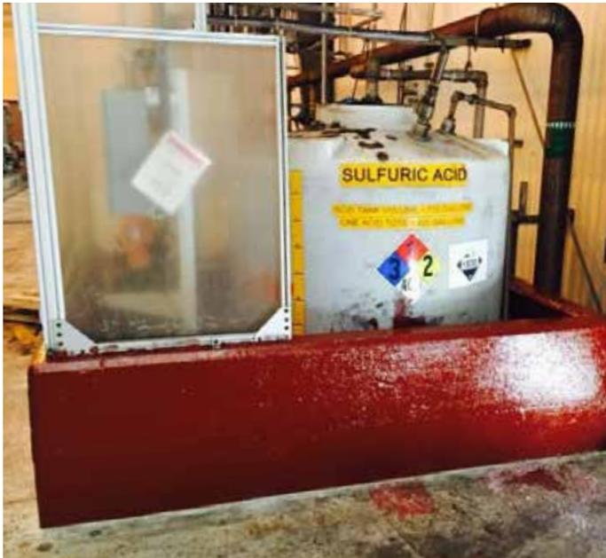
Belzona 4361 es un recubrimiento de barrera flexible diseñado para la protección de áreas de contención de sustancias químicas.
