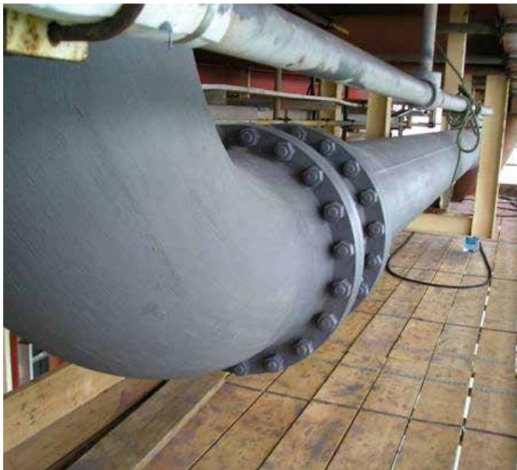
El recubrimiento de barrera Belzona 5841, de dos componentes, ha sido diseñado para la protección de superficies metálicas.
