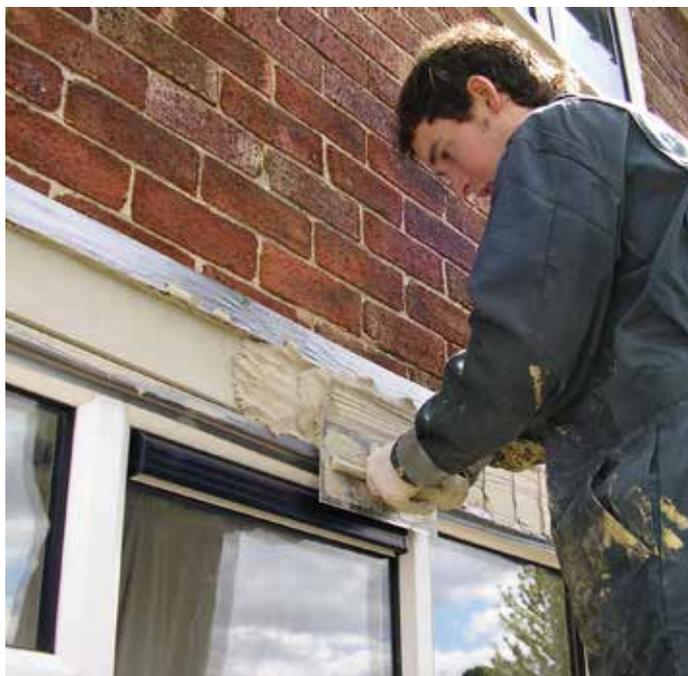
Belzona 4141 (Magma-Build) es un compuesto de reparación liviano, de dos componentes, diseñado para la reconstrucción de superficies de hormigón verticales o suspendidas que presentan deterioro. Este sistema para construcción en altura simplifica las aplicaciones al tiempo que proporciona protección de larga duración.
